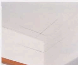
2. Используя карнизы, сделайте пометки на стене и потолке.
