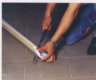
3. Отрежьте карниз по отметке.
