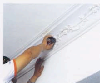
9. Для шлифовки поверхности используйте наждачную бумагу.
