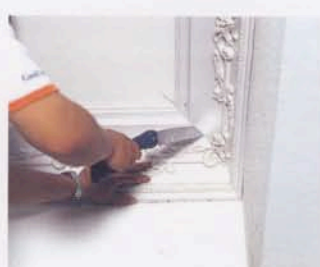
6. Подгоните концы для четкого стыка (соединения).
