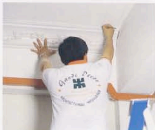
1. Сделайте отметки на карнизах для соединения углов.
