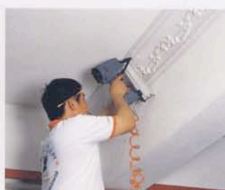
5. Используйте пневматический пистолет для забивания гвоздей.
