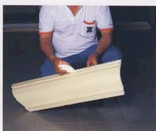
4. Нанесите клей вдоль по краям обратной стороны карниза, а также на поверхность, которую будете клеить.
